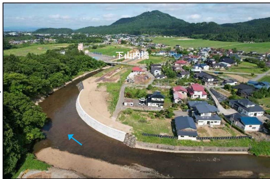
【下山内橋上流の施工状況】
