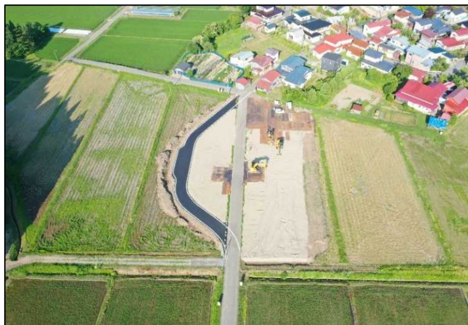
【橋台施工前の迂回路設置状況】
