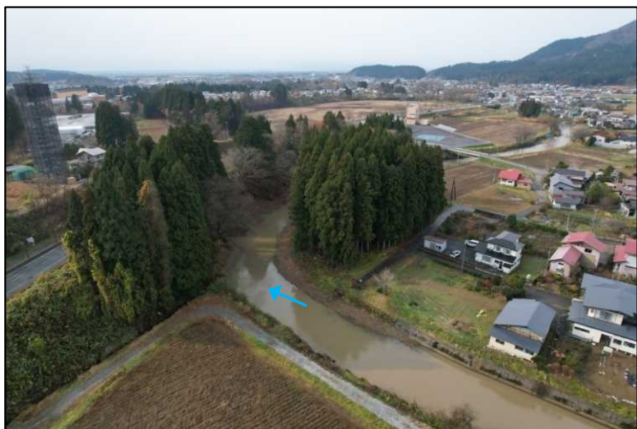
【下山内橋上流の着手前状況】
