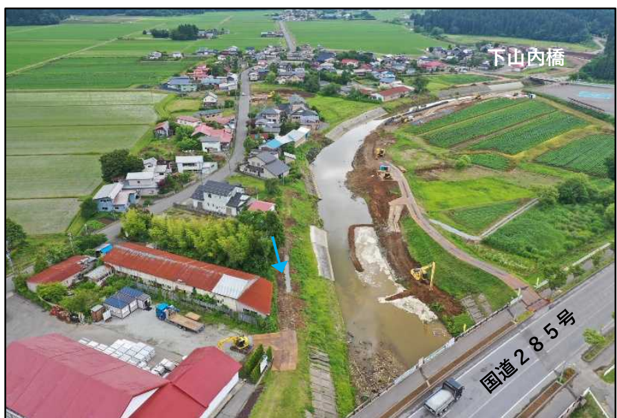
【下山内橋下流の施工状況①】
