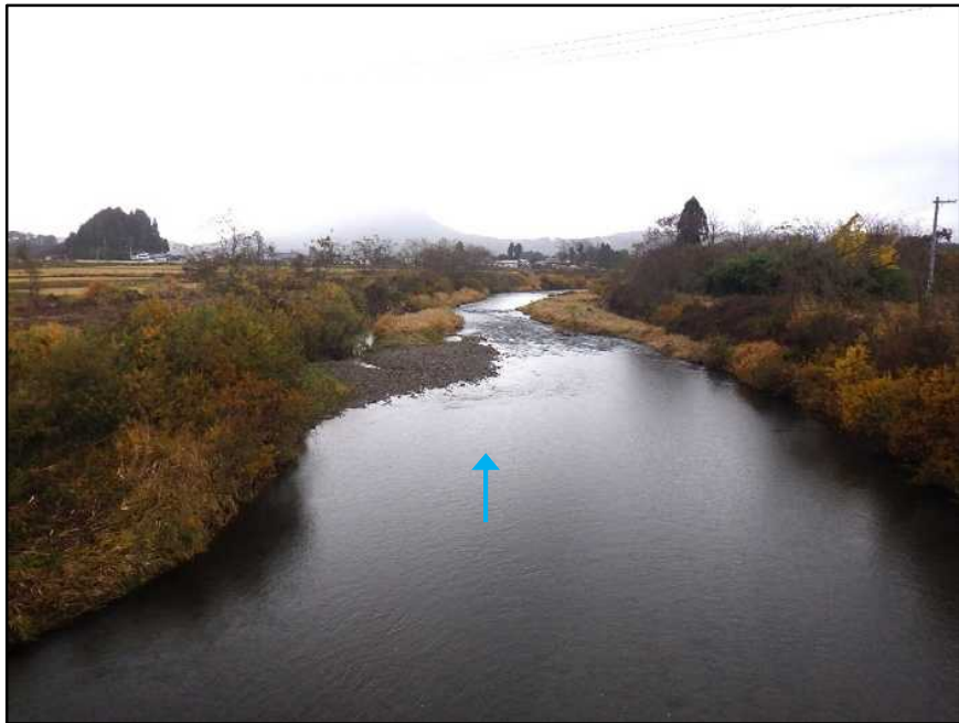
【久保橋下流の着手前状況】
