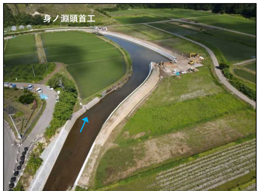
【身ノ淵頭首工付近の施工状況】
