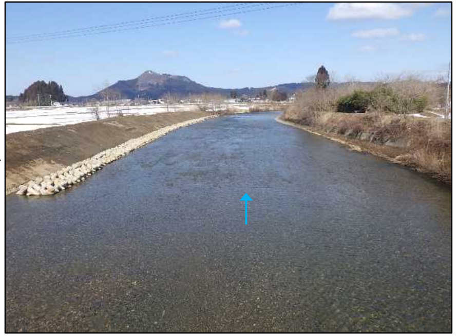
【久保橋下流の掘削完成状況】
