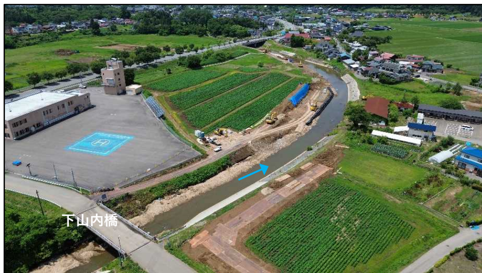
【下山内橋下流の施工状況②】
