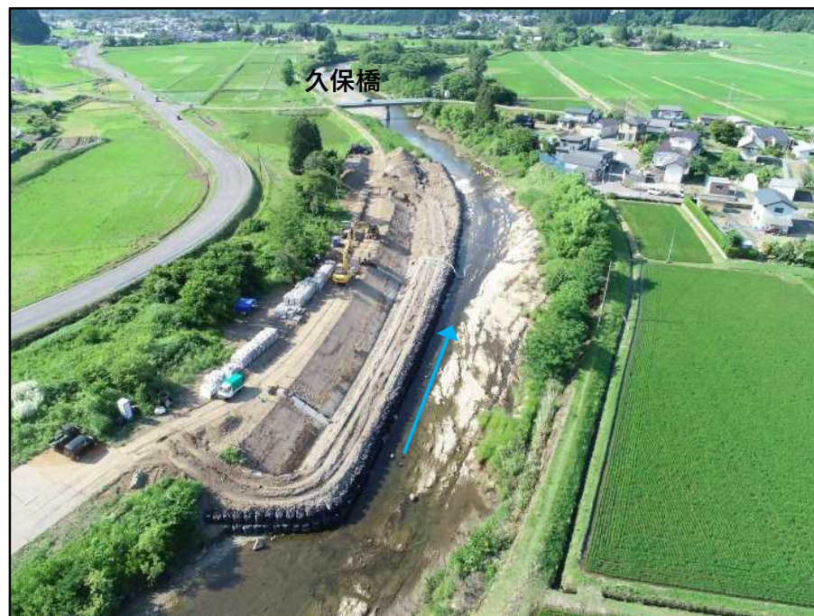
【久保橋上流の施工状況】
